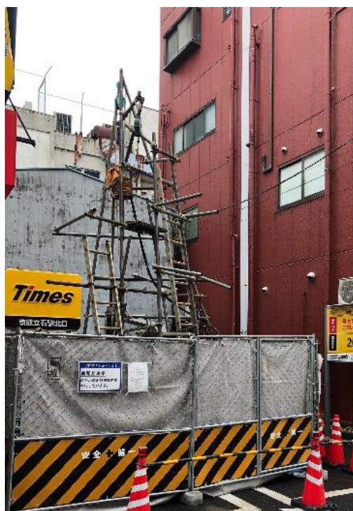
現地ボーリング調査の様子(11月末)
