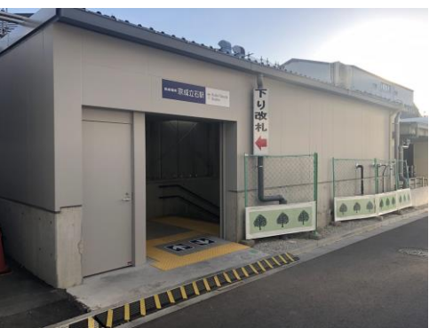
下り改札 (地下) 出入口 《階段》
