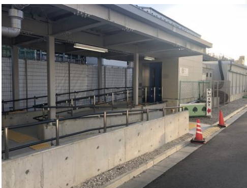
下り改札 (地下) 出入口 《エレベーター》
