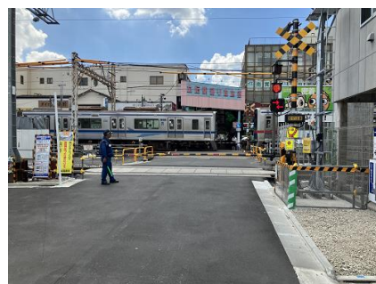
遮断機移設後の踏切
