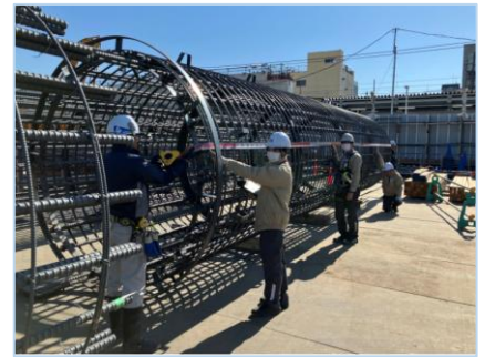
杭工事（西街区）
