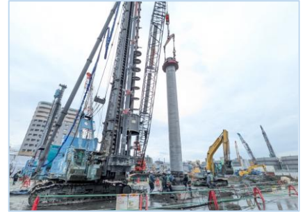
杭工事（東街区）
