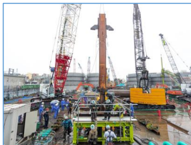
杭工事(交通広場)
