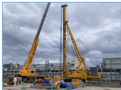
地盤改良工事(西街区)
