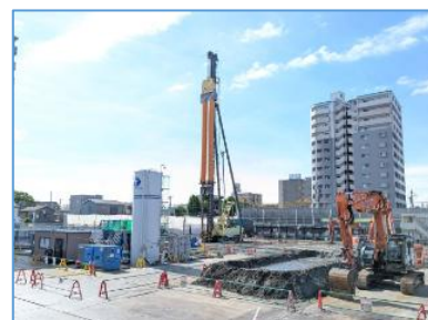
地盤改良工事(東街区)
